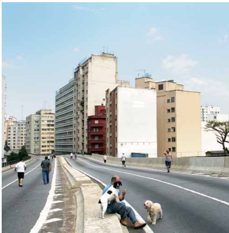
ESPAÇOS PÚBLICOS. O Minhocão, no centro de São Paulo, prefeitura da cidade estuda demolir a estrutura para revitalizar e elevar a qualidade de vida na região
